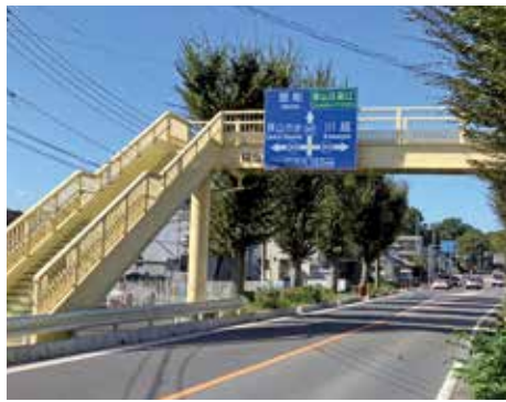
歩道橋改修工事
