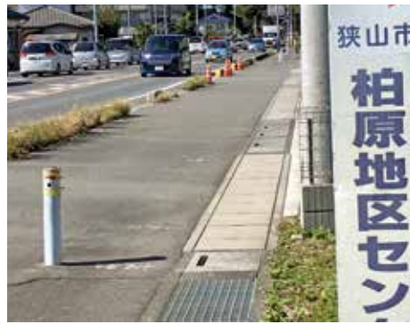
歩道整備と雨水対策
