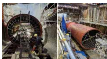
破損した下水道管の代わりに敷設した新しい下水道管(鋼製セグメント)
